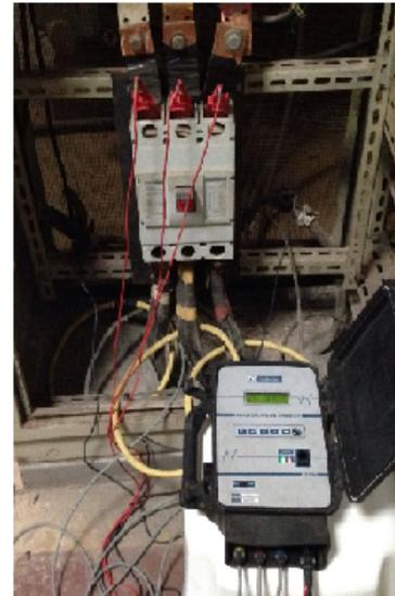
(b) Medição no PCC através do analisador RE6081
